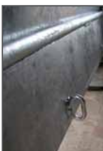
aangelaste kettingschakel
