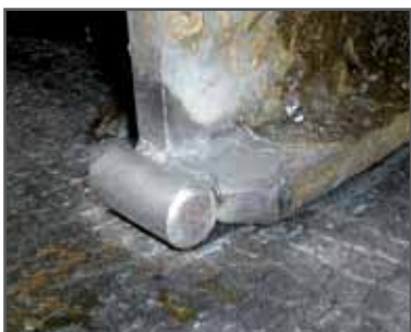
glijvoet met ronde staaf en breed steunoppervlak
