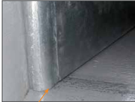
zij mestkleppen let op: scherpe kanten (-> afronden)
