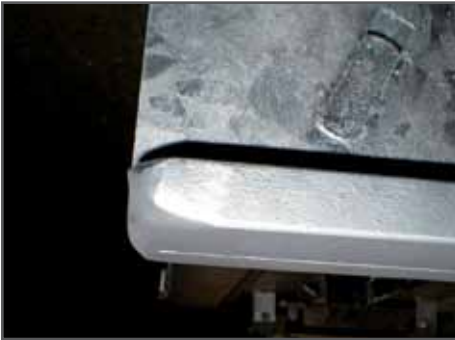
de steunvlakken van de glijvoet zijn afgerond
